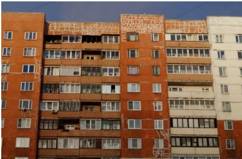
Рис. 3. Повреждение панелей в зданиях первых массовых серий
