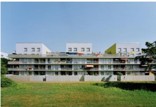
**Рис. 7.** Пример увеличения площади квартир за счет устройства приставных балконов и открытых террас
